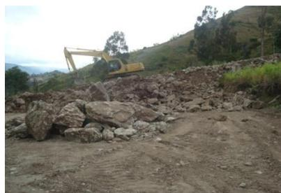
**Fig. 16.** *Trabajos de movimientos de tierras en lugares rocosos*
