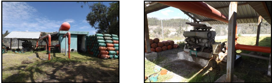
Figura 19: Unidad de bombeo.
