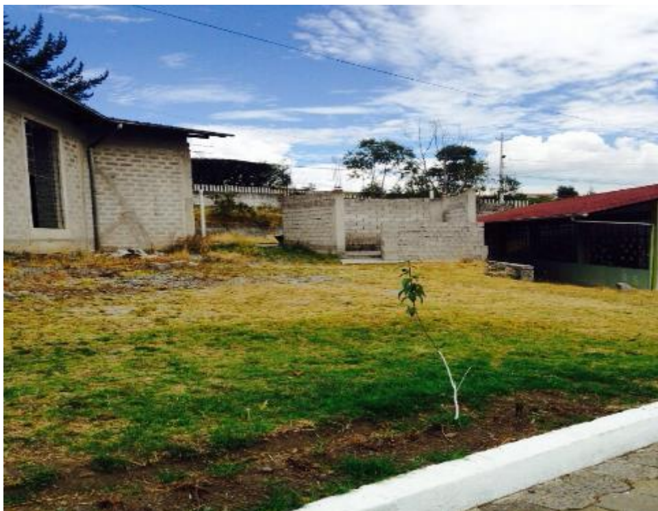
Figura 12. Construcciones sin concluir en el HAMSIL. Fuente: HAMSIL, 2014.
