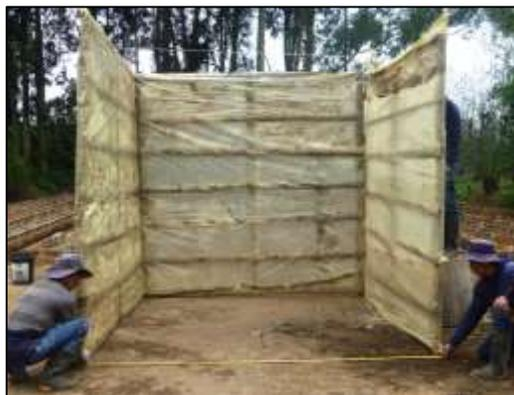
Figura 7. Dimensiones y materiales de los cercos: 2.50m de alto x 2.50m de ancho con madera y Plástico.
