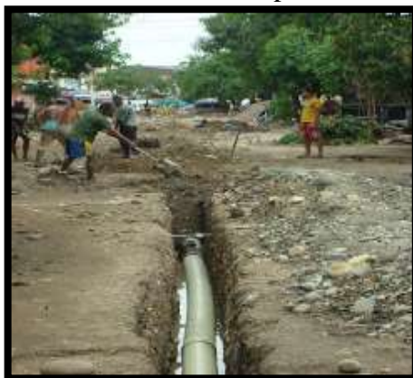
Figura 2.1 Tubería enterrada por dentro del suelo.
