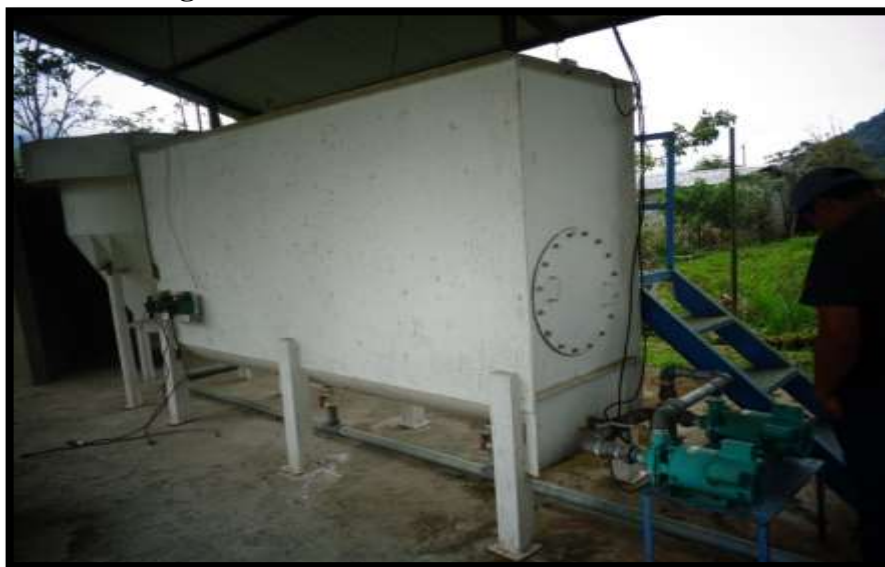
Figura 1.3 Planta de tratamiento en mal estado.
