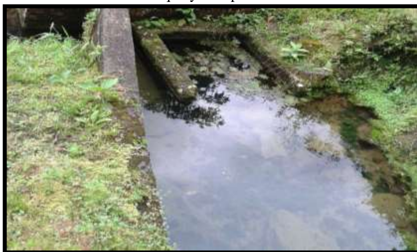
Figura 1.2 Mal estado del tanque y la captación del abastecimiento del agua.
