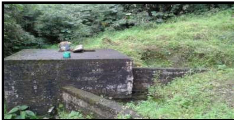
Figura 3.1 Tanque y captación en malas condiciones sin protección.
