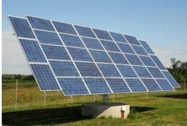
Figura 3. Sistema de posicionamiento de paneles para elevar energía en hospital.
