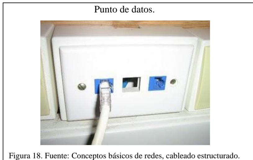
Para el sistema de cableado estructurado se toma en cuenta al punto de datos normal el cual está conformado por un cajetín cuadrado de 10x10cm, el montaje empotrado en pared a una altura mínima de 30cm y sobrepuesto en los techos, una placa de una o dos posiciones (face plate) en la cual se coloca uno o dos jacks modulares hembra RJ45 de categoría 6a correctamente etiquetados.
