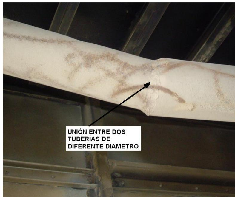
**Figura 1.20** Contrapresión generada por unión entre dos tuberías de diferente diámetro
