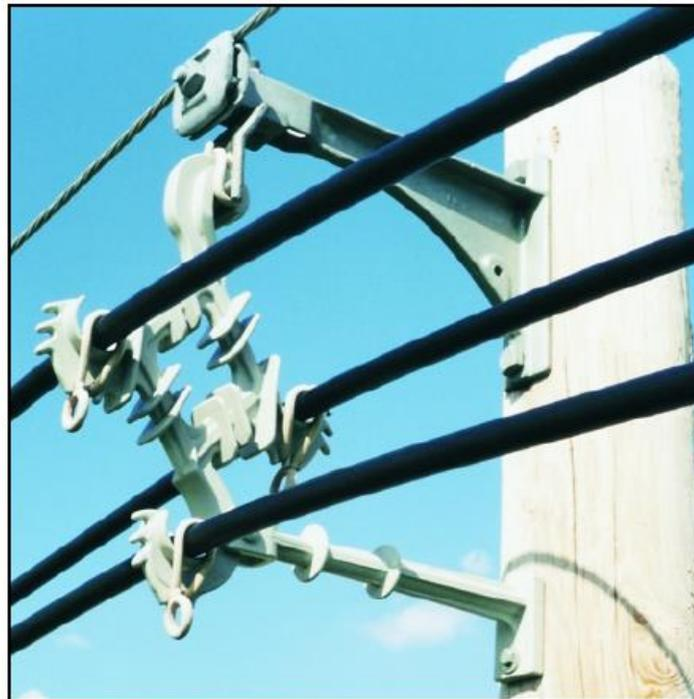
Figura 11. Descripción del sistema de cables aéreos con espaciadores
