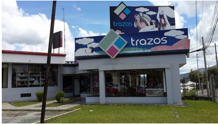
Vista panorámica del almacén en el Parque Industrial
