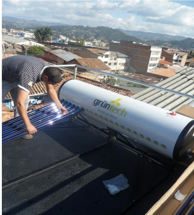
*Figura 3.8 Instalación de tubos calentador solar*
