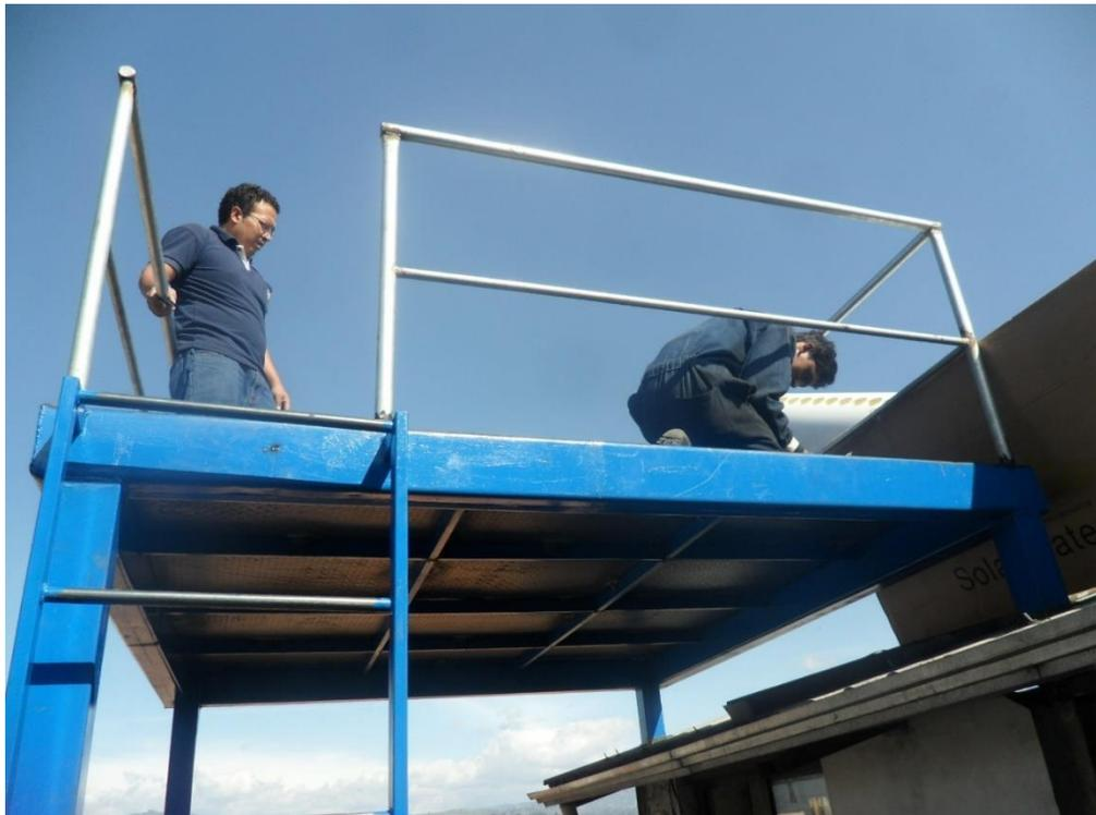
Figura 3.7 Base de soporte de calentador solar de tubos de vacío
