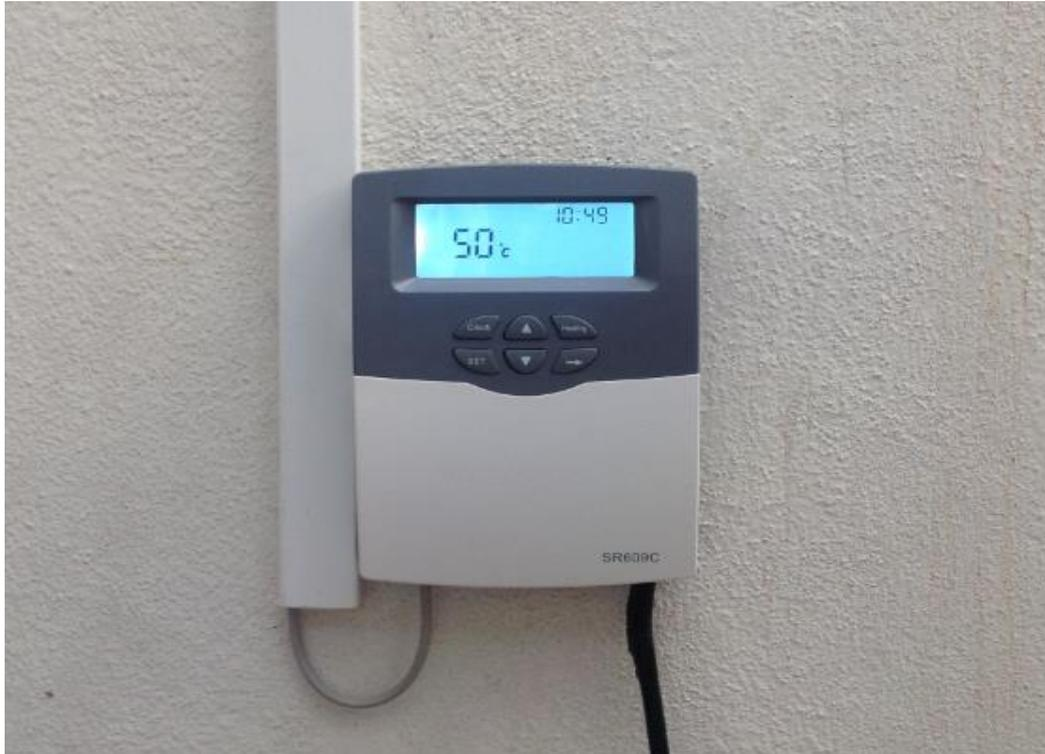
*Figura 3.14. Controlador calentador solar de tubos de vacío con tubo de calor*
