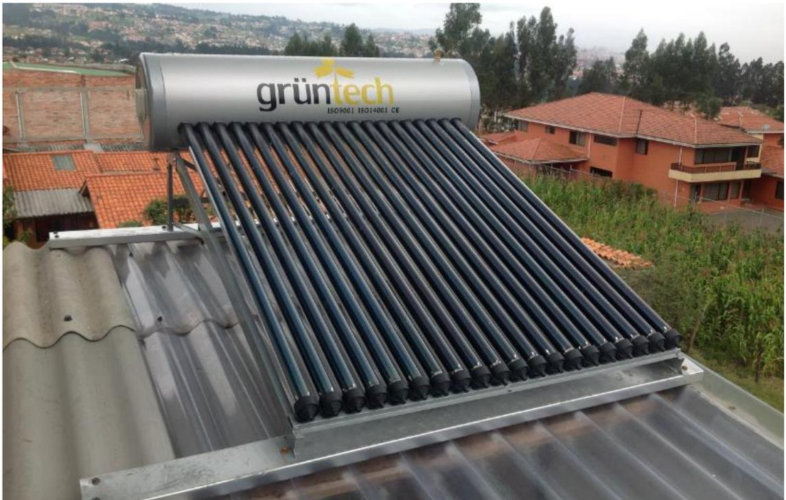
*Figura 3.13. Calentador solar de tubos de vacío con tubo de calor*
