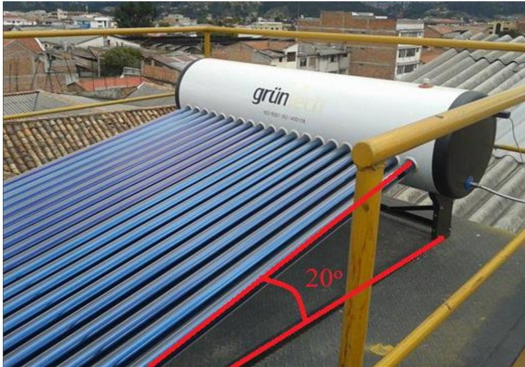
*Figura 3.9 Angulo de inclinación del calentador solar*
