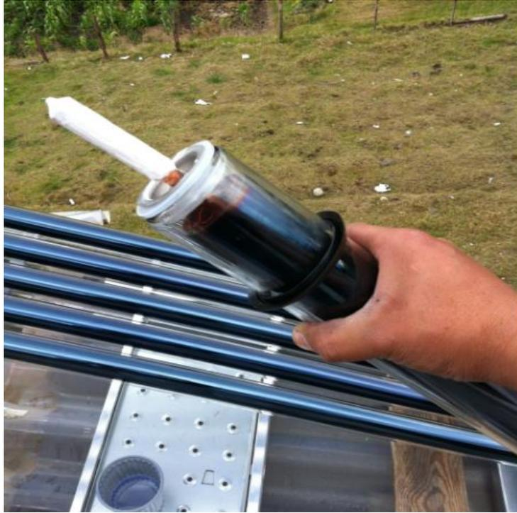
*Figura 3.12 Aplicación de pasta térmica en el condensador del tubo de calor*
