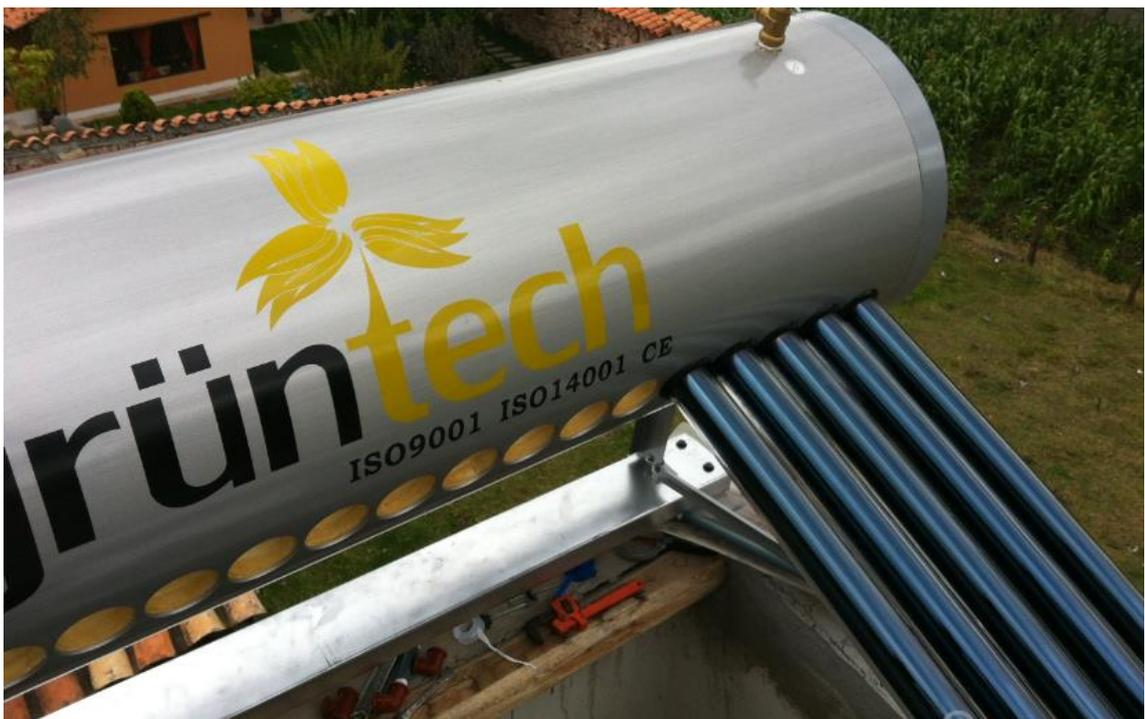
*Figura 3.11 Armado de calentador solar de tubos de vacío con tubo de calor*
