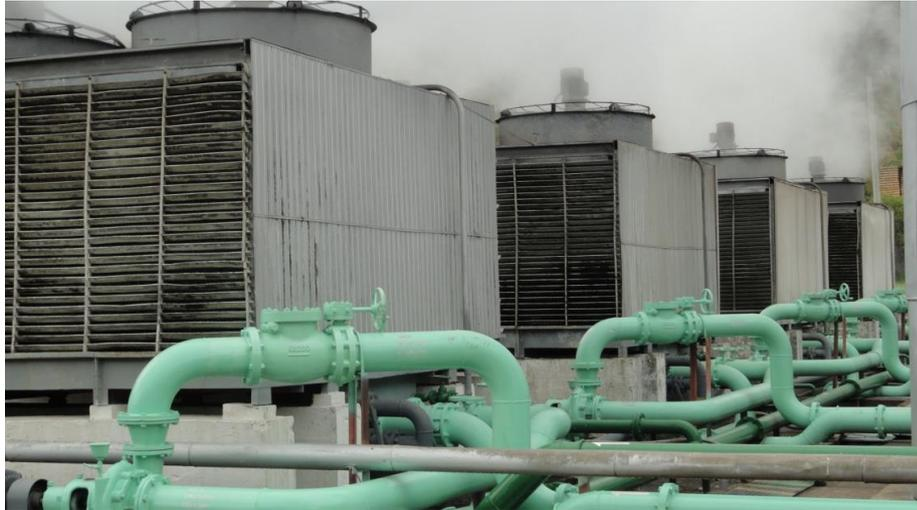
**Figura 4.9** Tuberías de agua para refrigeración de los sistemas auxiliares de los motores estacionarios. [22]
