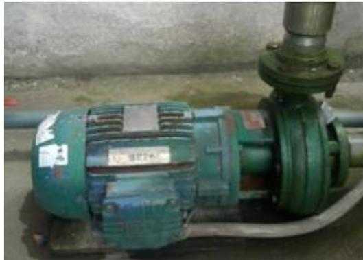
Ilustración 7. Gráfico 1.7 Bomba de agua de pasteurizador Fuente: Autor
