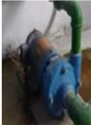
Ilustración 17. Gráfico 1.17 Bomba de agua de hidroneumático Fuente: Autor
