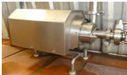
**Ilustración 38. Gráfico 1.38 Bomba de leche Mecatec Fuente: Autor**
