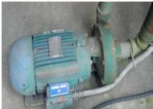
Ilustración 8. Gráfico 1.8 Bomba de agua de intercambiador 1. Fuente: Autor
