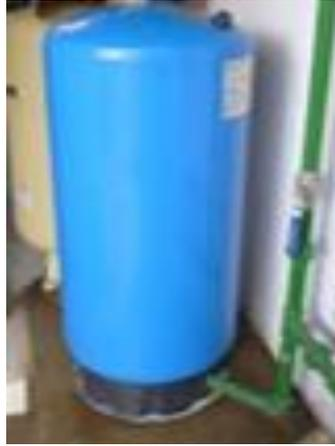
Ilustración 18. Gráfico 1.18 Hidroneumático
