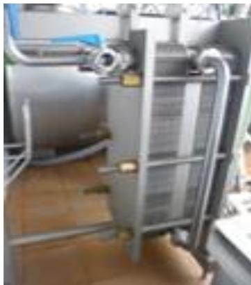
Ilustración 23. Gráfico 1.23 Intercambiador Alfa Laval Fuente: Autor
