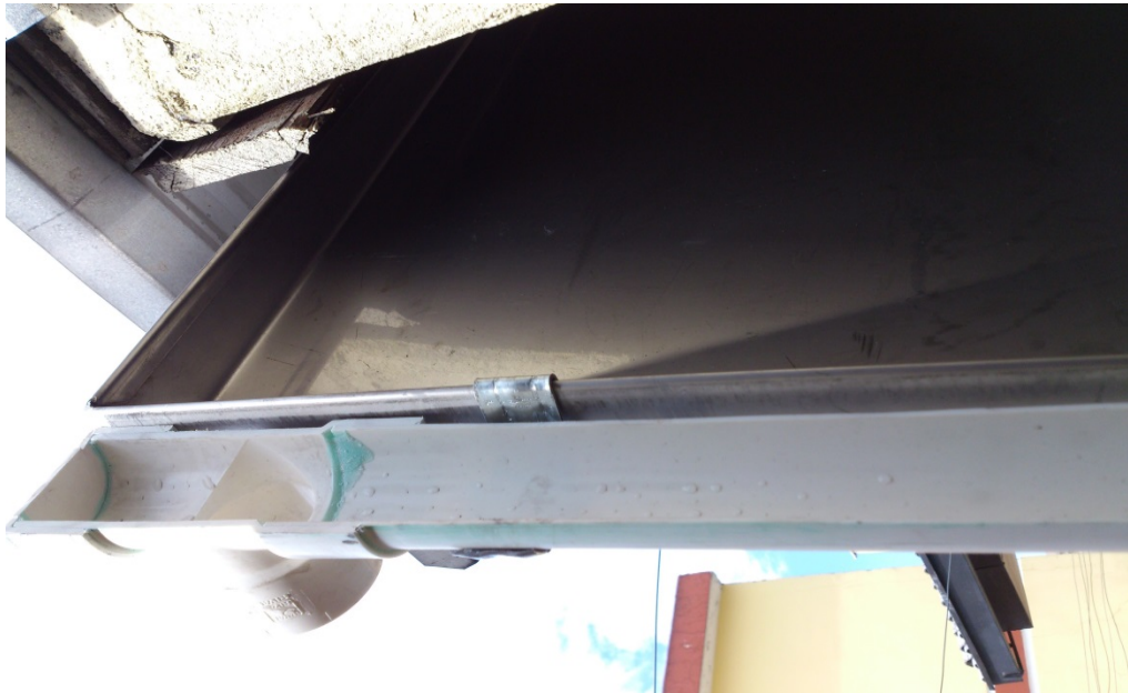
Figura 4.11 Ensamble de la bandeja con los canales
