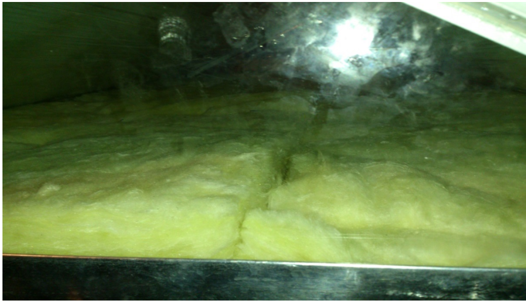
Figura 4.12 Ensamble de la lana de vidrio
