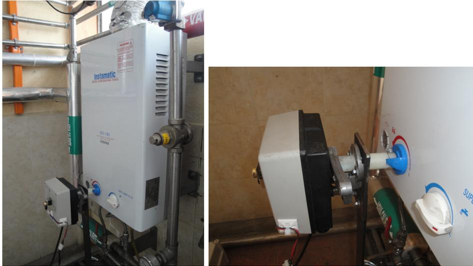
(a) Calentador de agua con servomotor adaptado
