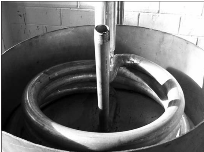
Tubo de enfriamiento a serpentin
