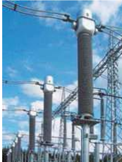
Figura 1. 5 Instalación de transformador de corriente
