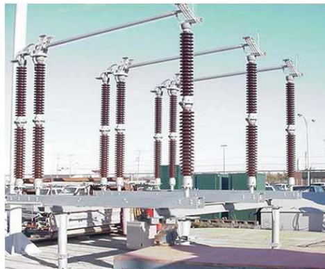
Figura 1. 15 Seccionador de apertura vertical
