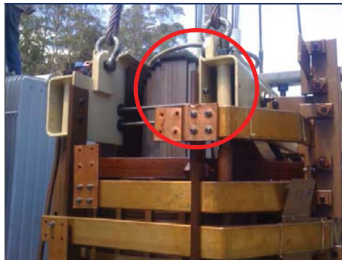
Figura 1. 1 Núcleo de Transformador de Potencia
