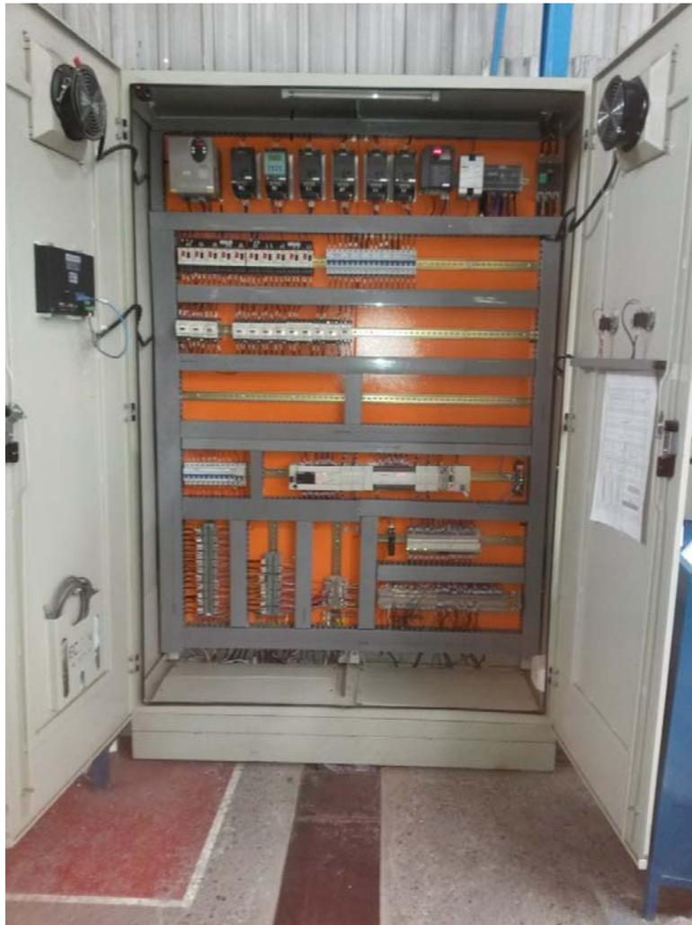
**Figura 4.13** Tablero eléctrico que controla todo el proceso de ensamble e ingreso de producto terminado a bodega
