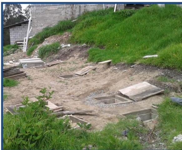
*Ilustración 8. Pozo Séptico de Tratamiento de Aguas Residuales.*
