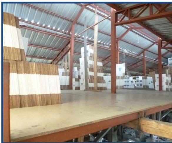
***Ilustración 36. Plataforma sin Barandillas ni Rodapiés.***
