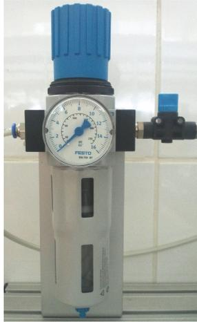
Figura 1.1: Unidad de Mantenimiento para el sistema Neumático.
