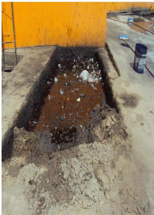
**Figura 2.48:** Lubricadora Cañar, fosa en donde son desechados los recipientes y filtros de aceite.
