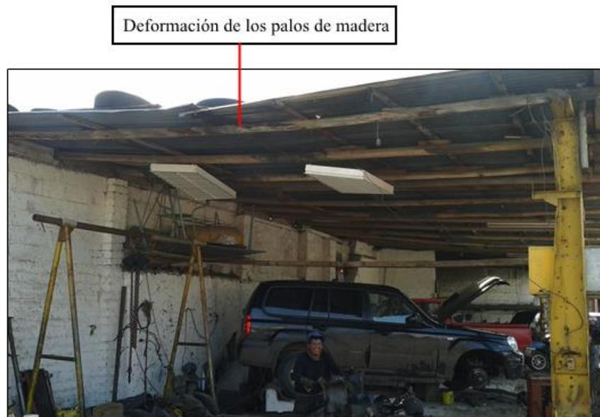
**Figura 3.2** Cubierta en mal estado en zonas de trabajo
