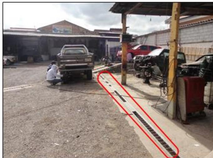
**Figura 1.19** Rejillas para la evacuación de aguas lluvias
