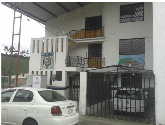
Figura 41. Punto de acopio recomendado en el barrio buenaventura Elaboración: Por los autores
