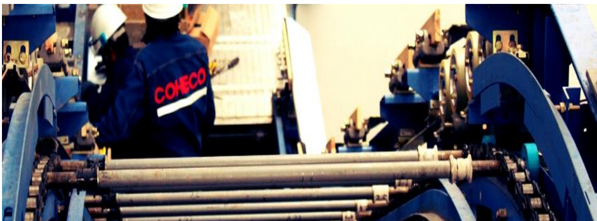
Figura 22. Montaje de escaleras eléctricas
