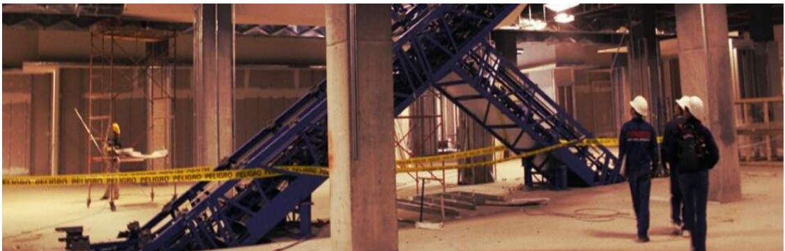
Figura 17. Inspección a obra en construcción
