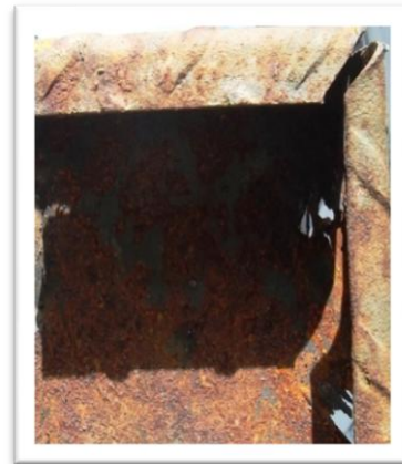
Figura 2.37 Dobleces plancha corrugada Fuente: Autores
