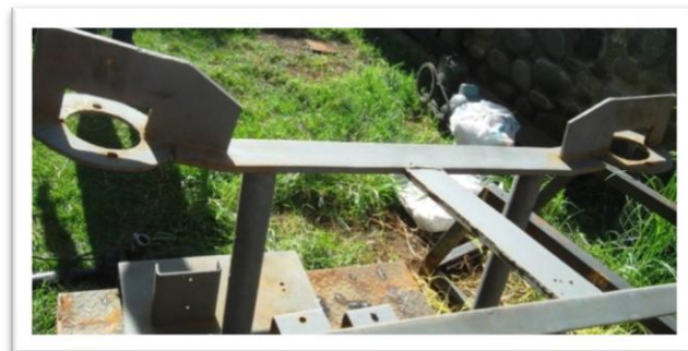
Figura 2.40 Montaje de la estructura Fuente: Autores
