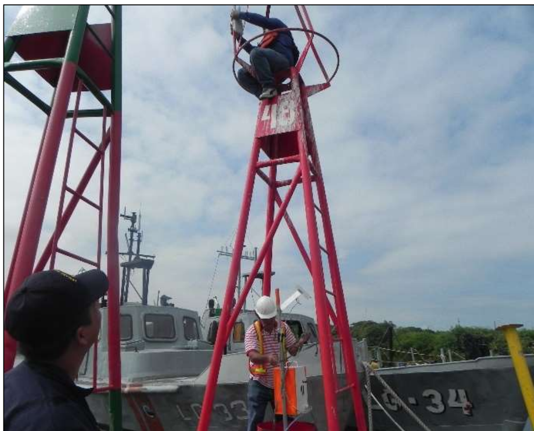
Figura 96. Instalación de la estación acuática en una de las boyas de aviso, sobre el Estero Salado de Guayaquil en la Base Naval (INOCAR).
