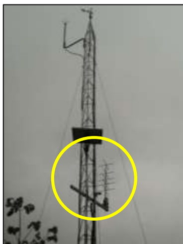
Figura 10. Antena Satelital del sistema GOES.
