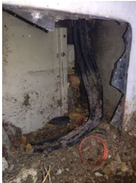
Fotografía 4.83 Caja de paso CP-3 (Parqueadero UEDC) Fuente: Los Autores
