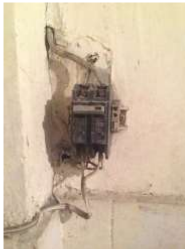
Fotografía 4.81 Disyuntores externos (Parqueadero UESDC) Fuente: Los Autores
