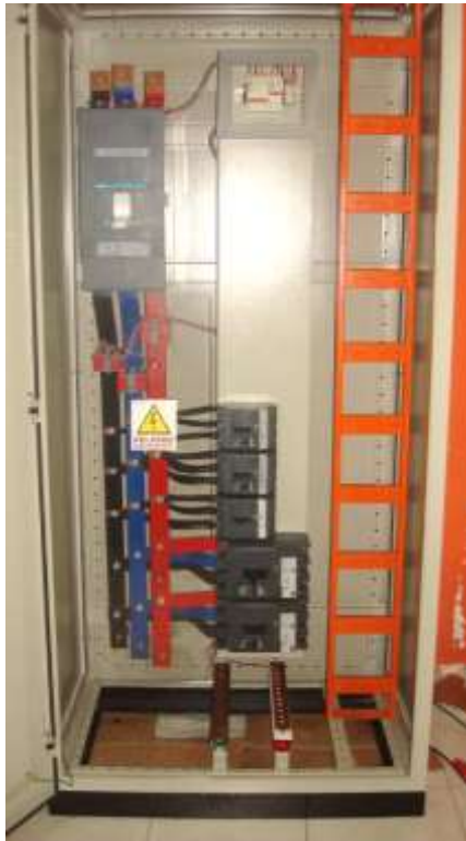
Fotografía 2.1 Tablero distribución principal Fuente: Los Autores
