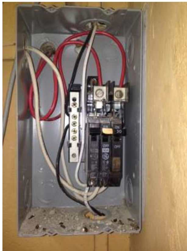
Fotografía 4.72 Panel Inspección General
