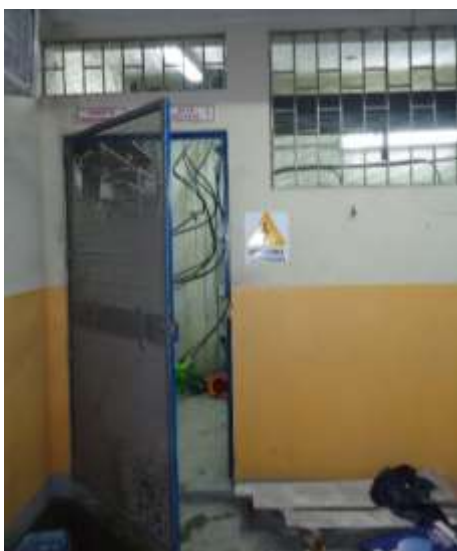
Fotografía 4.5 Cuarto de transformación Fuente: Los Autores
