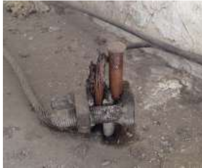
Fotografía 4.13 Sistema de puesta a tierra Fuente: Los Autores
