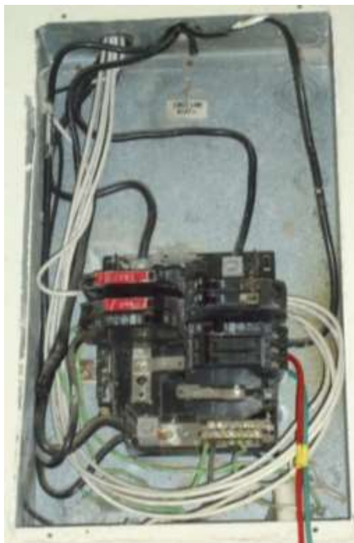
Fotografía 4.36 Panel #1 Departamento de Logística y Mantenimiento Fuente: Los Autores
