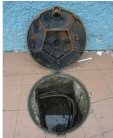
Fotografía 4.3 Acometida Subterránea Fuente: Los Autores
