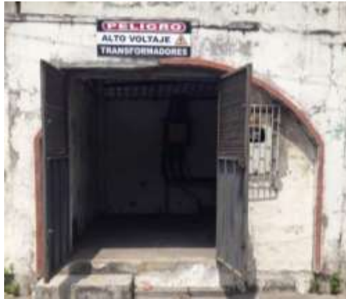
Fotografía4.11 Cuarto de transformación UPS Fuente: Los Autores
