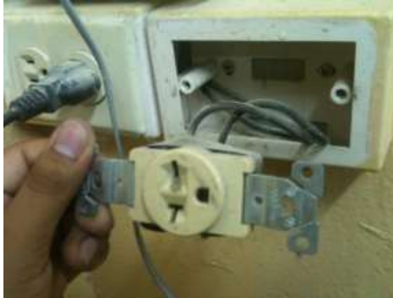
Fotografía 4.82 Tomacorriente de 240v sin neutro Fuente: Los Autores
