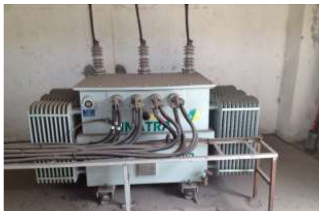
Fotografía 4.12 Transformador trifásico de 500KVA
