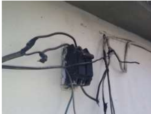
Fotografía 4.80 Disyuntores externos (Parqueadero UESDC) Fuente: Los Autores
