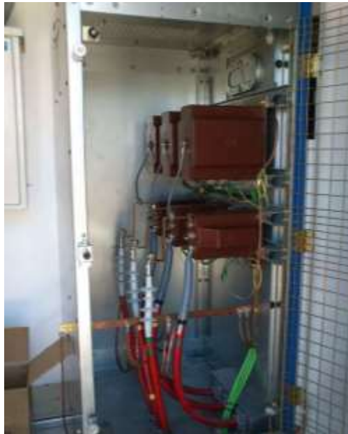
Figura 5.1 Celda de Medición Fuente: Los Autores
