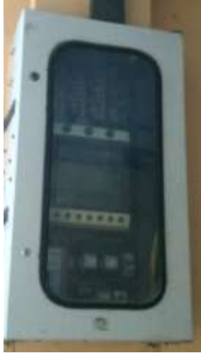
Fotografía 4.26 TDS-5 Tablero cerrado Fuente: Los Autores
