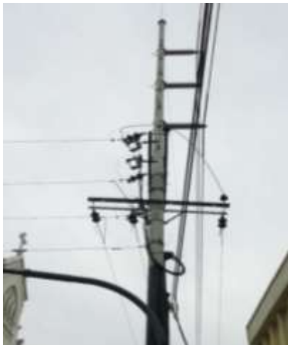
Fotografía 4.2 Acometida Aérea Fuente: Los Autores
