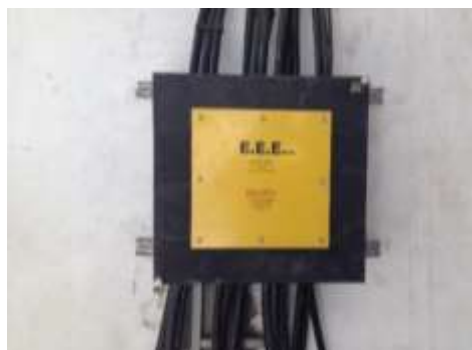
Fotografía 4.14 Transformadores de corriente Fuente: Los Autores
