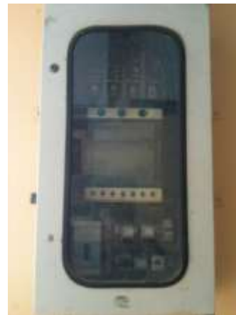
Fotografía 4.29 TDS-6 Tablero abierto Fuente: Los Autores
