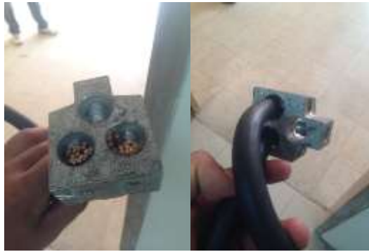
Fotografía 4.84 Empalmes en conductores calibres 3/0 Fuente: Los Autores
