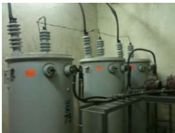
Fotografía 4.6 Banco de transformadores trifásicos de 75KVA Fuente: Los Autores
