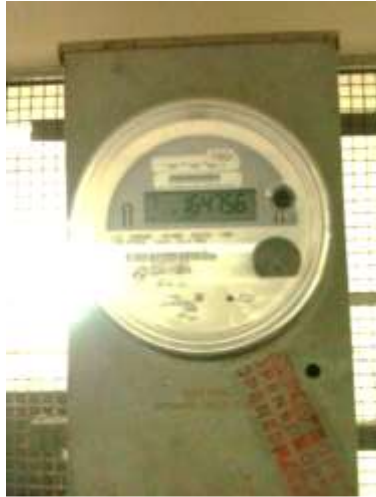
Fotografía 4.10 Contador de energía UEDC Fuente: Los Autores
