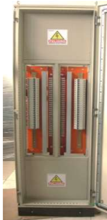
Fotografía 2.2 Tablero distribución secundaria Fuente: Los Autores
