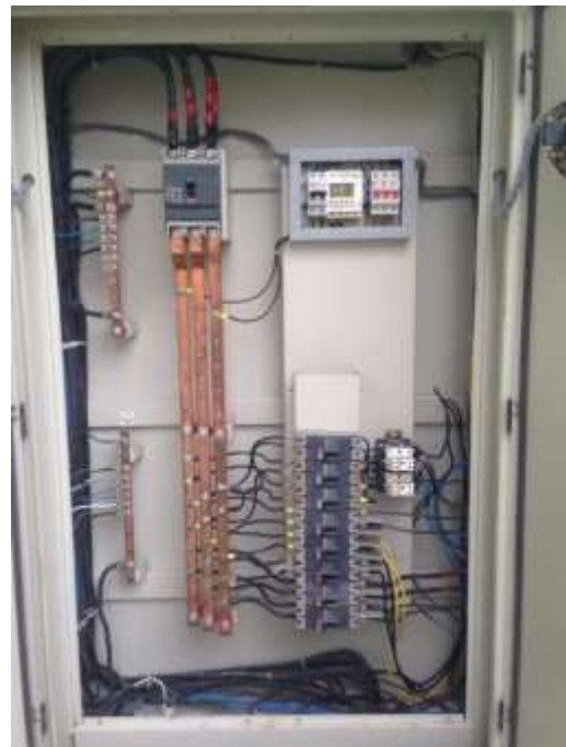
Fotografía 4.31 TDS-7 Tablero abierto Fuente: Los Autores
