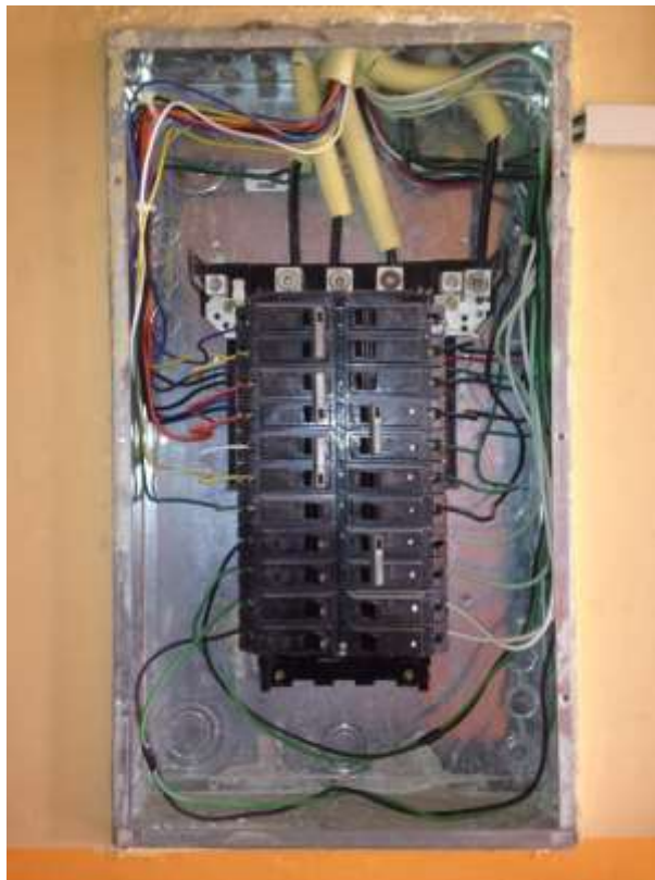
Fotografía 4.78 Panel Pasillo Central-Sur
