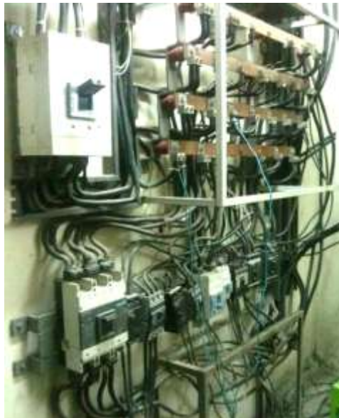
Fotografía 4.16 Tablero de Distribución Principal TDP-1 Fuente: Los Autores
