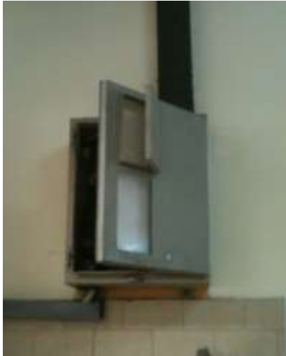
Fotografía 4.21 TDS-2 Tablero cerrado Fuente: Los Autores
