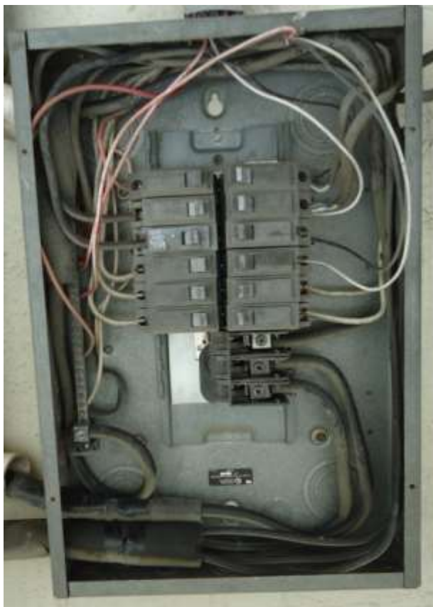
Fotografía 4.75 Panel Plataforma de Aires
