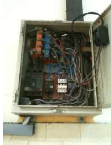
Fotografía 4.22 TDS-2 Tablero abierto Fuente: Los Autores
