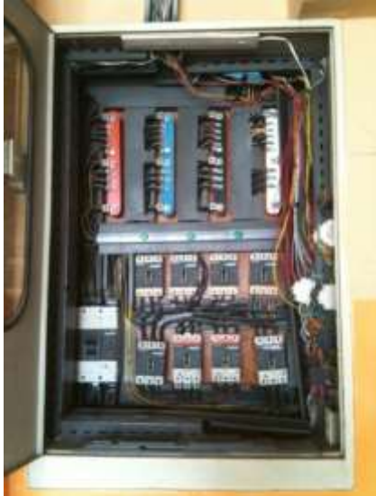
Fotografía 4.24 TDS-4 Tablero cerrado Fuente: Los Autores
