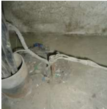
Fotografía 4.7 Puesta a tierra del banco de transformadores Fuente: Los Autores
