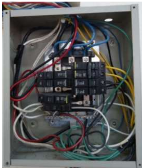
Fotografía 4.41 Laboratorio de Cómputo #2 Fuente: Los Autores
