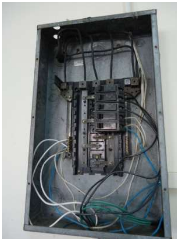
Fotografía 4.49 Laboratorio de Cómputo #3 Panel #1 Fuente: Los Autores
