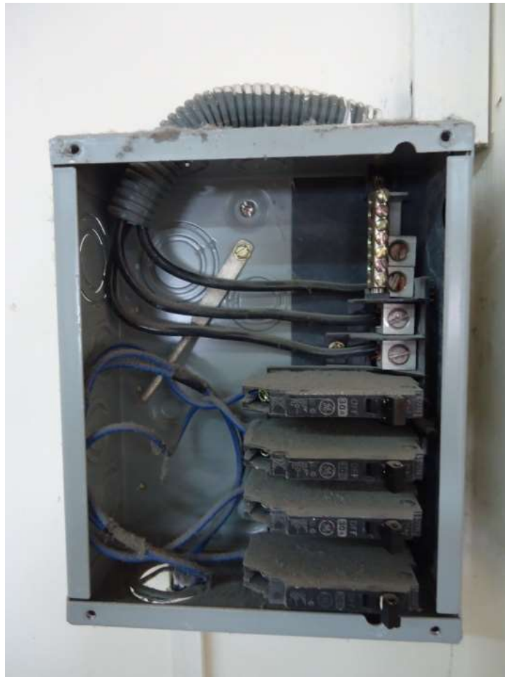
Fotografía 4.67 Panel Aula Junto Cafetería Fuente: Los Autores
