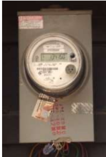
Fotografía 4.15 Contador de energía UPS Fuente: Los Autores
