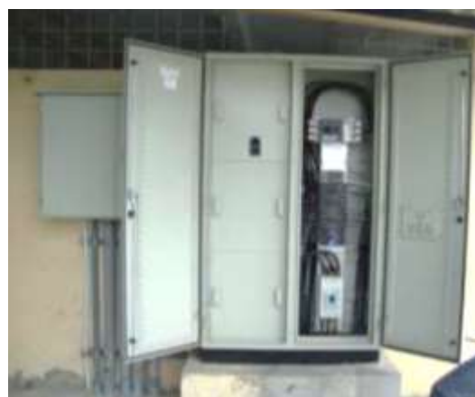
Fotografía 4.18 Módulo#2 del TDP-2 Fuente: Los Autores
