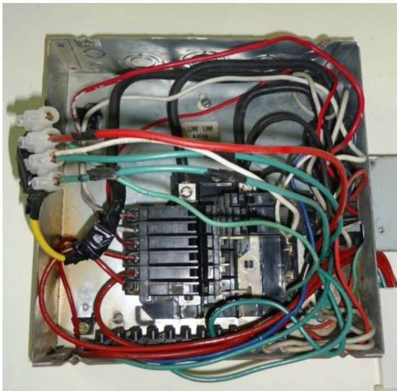
Fotografía 4.44 Laboratorio de Cómputo #4 Fuente: Los Autores
