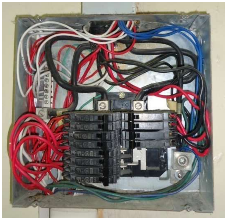
Fotografía 4.45 Laboratorio de Cómputo #5 Fuente: Los Autores
