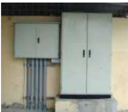
Fotografía 4.17 Módulo#1 del TDP-2 Fuente: Los Autores
