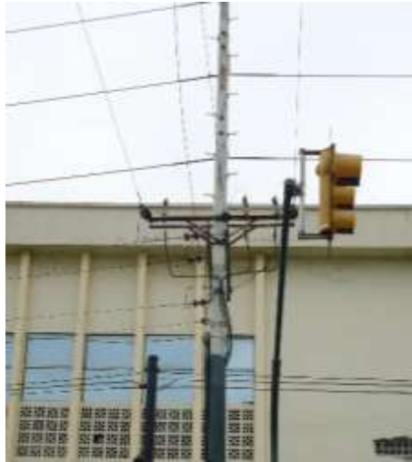
Fotografía 4.1 Acometida Principal 13.8 KV Empresa Eléctrica Guayaquil E.P. Fuente: Los Autores
