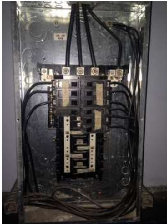
Fotografía 4.74 Salón de Usos Múltiples Climatización
