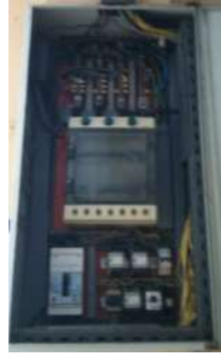
Fotografía 4.27 TDS-5 Tablero abierto Fuente: Los Autores
