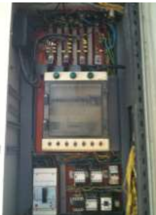
Fotografía 4.28 TDS-6 Tablero cerrado Fuente: Los Autores
