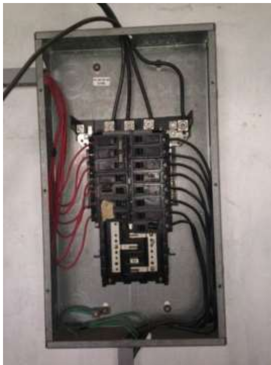
Fotografía 4.79 Panel Climatización Salón de Usos Múltiples
