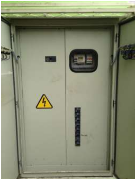
Fotografía 4.30 TDS-7 Tablero cerrado Fuente: Los Autores
