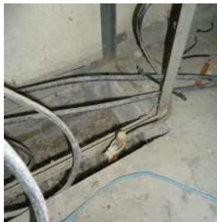
Fotografía 4.8 Puesta a tierra para Tableros de Distribución Secundaria Fuente: Los Autores
