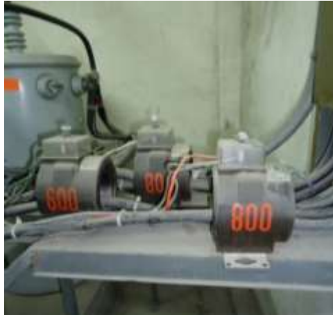
Fotografía 4.9 Transformadores de corriente Fuente: Los Autores
