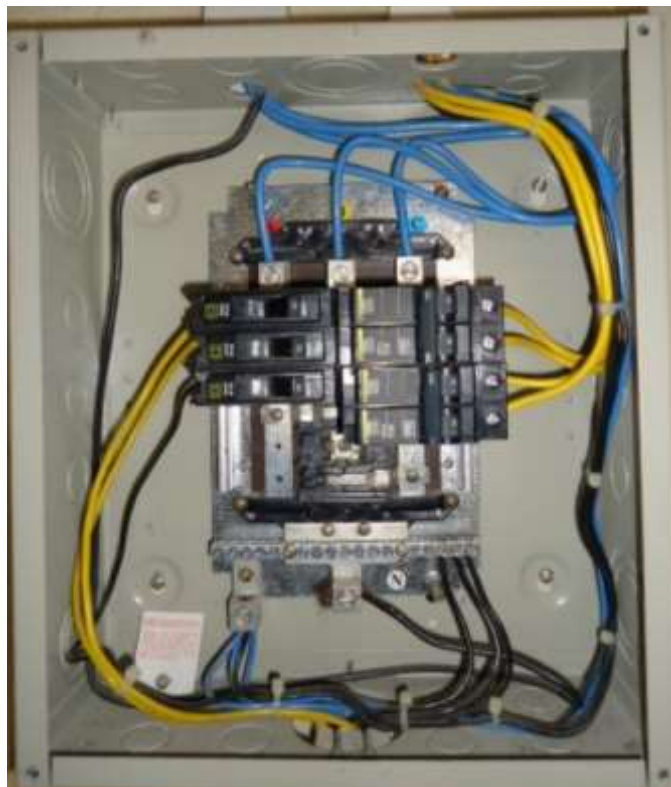
Fotografía 4.42 Laboratorio de Cómputo #1 Fuente: Los Autores
