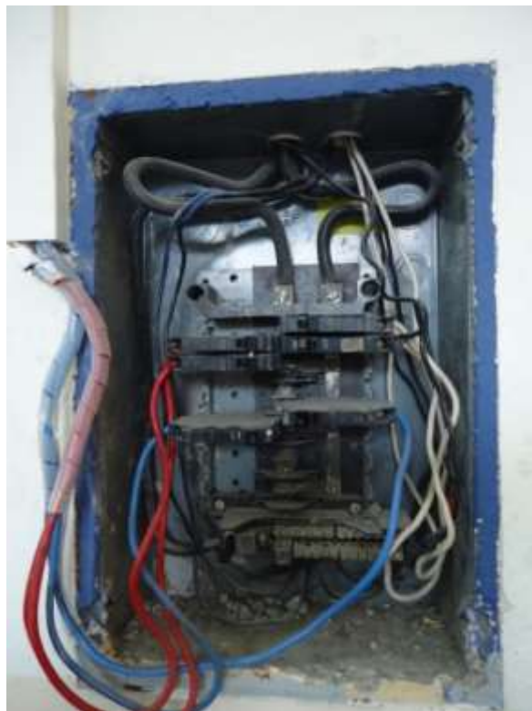
Fotografía 4.50 Laboratorio de Cómputo #3 Panel #2 Fuente: Los Autores
