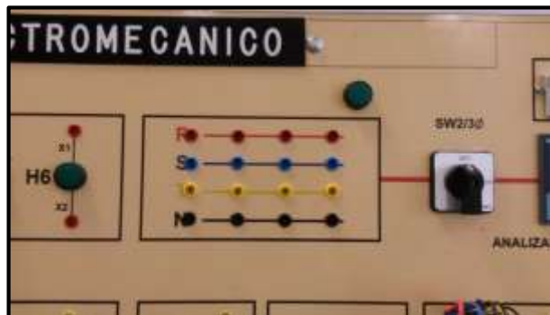
Ilustración 58 Centro de alimentación trifásica
