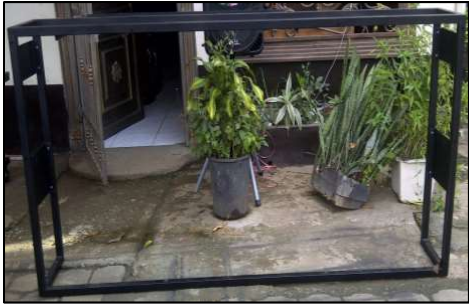
Ilustración 35 Elaboración de la estructura del banco
