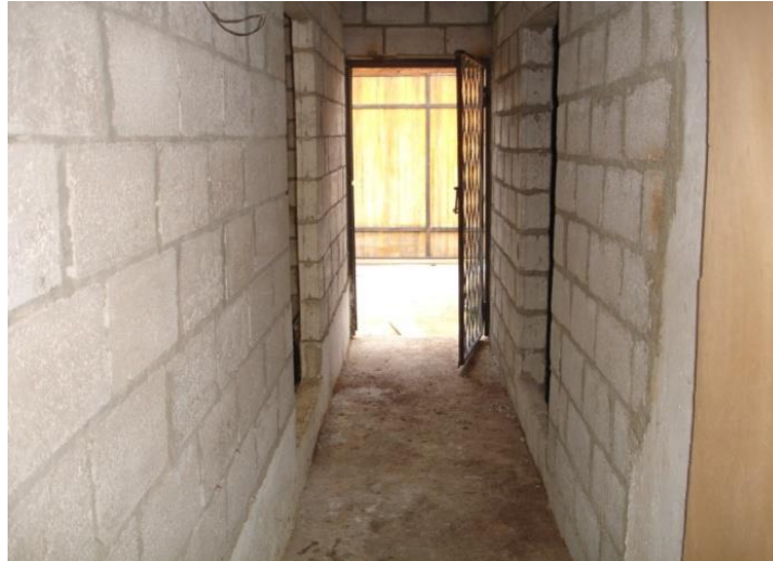
FOTO 1. 6■ infraestructura interior (pasillos)
