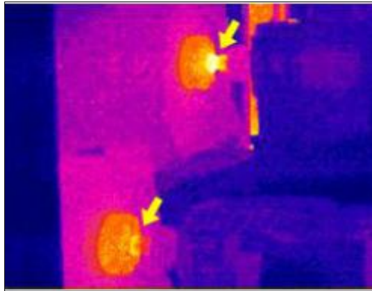
Figura 1.14. Análisis termográfico de una máquina rotativa. Fuente [27]
