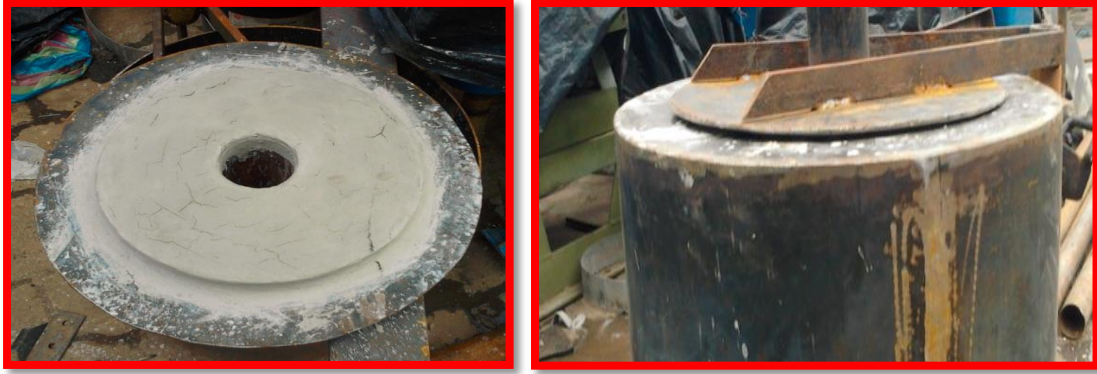
Figura 5.13. Montaje de la tapa del horno.
