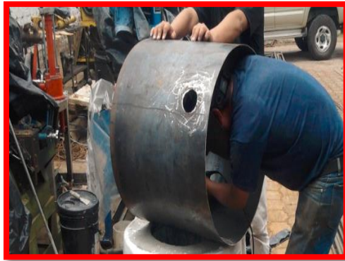
Figura 5.5. Construcción del cilindro metálico.
