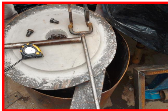
Figura 5.10. Construcción de placas para sistema de elevación de tapa.
