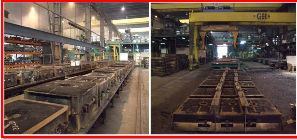
Figura 1.8. Vista parcial de una sección de Preparación de Arenas.
