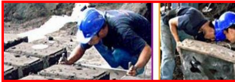
Figura 1.11. Colocación de noyos.
