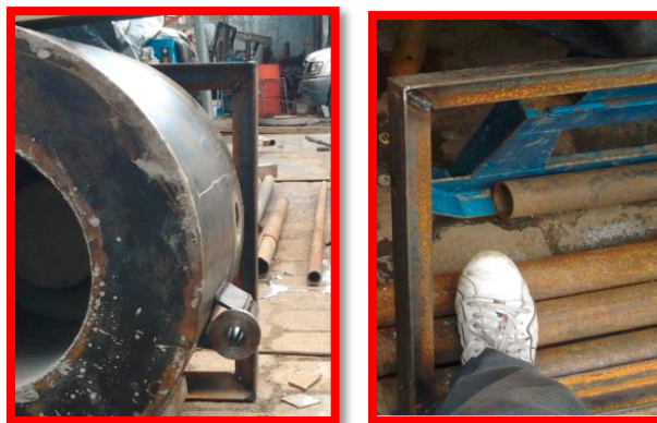
Figura 5.4. Construcción de la base porta horno.
