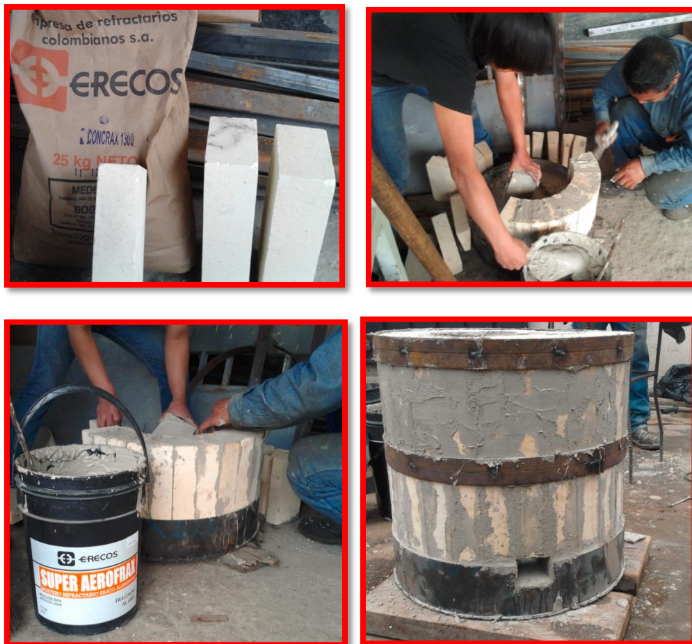
Figura 5.11. Montaje de la bóveda y base refractaria del horno.
