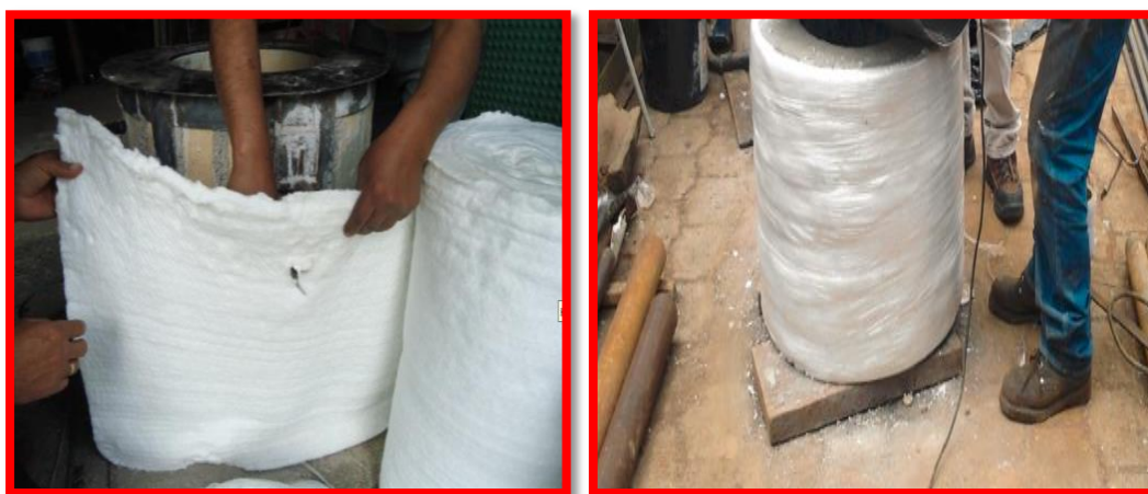
Figura 5.12. Montaje de la manta de cerámica.
