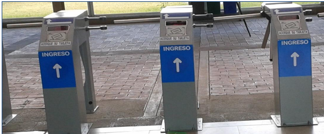
Figura 2-3 Torniquetes de ingreso a una Estación de Transferencia. Fuente: Autores.
