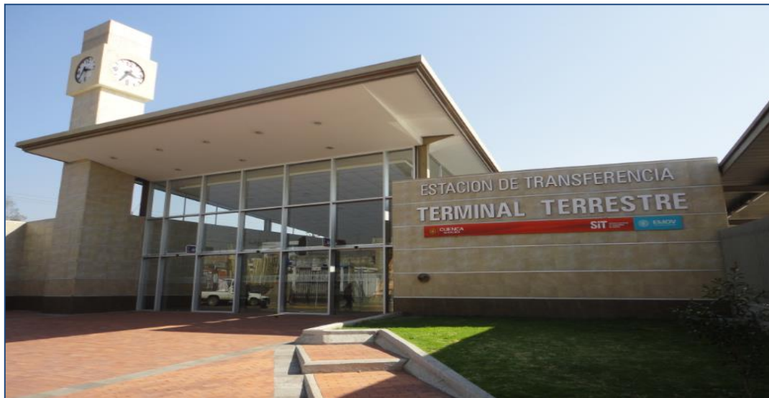
Figura 1-2 Estación de Transferencia “Terminal Terrestre”. Fuente: Autores.
