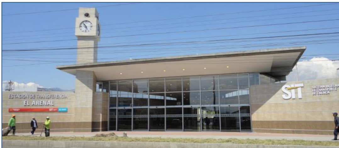
Figura 1-3 Estación de Transferencia “El Arenal”. Fuente: Autores.
