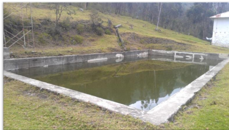
Fig. 2.11 Piscina de almacenamiento
