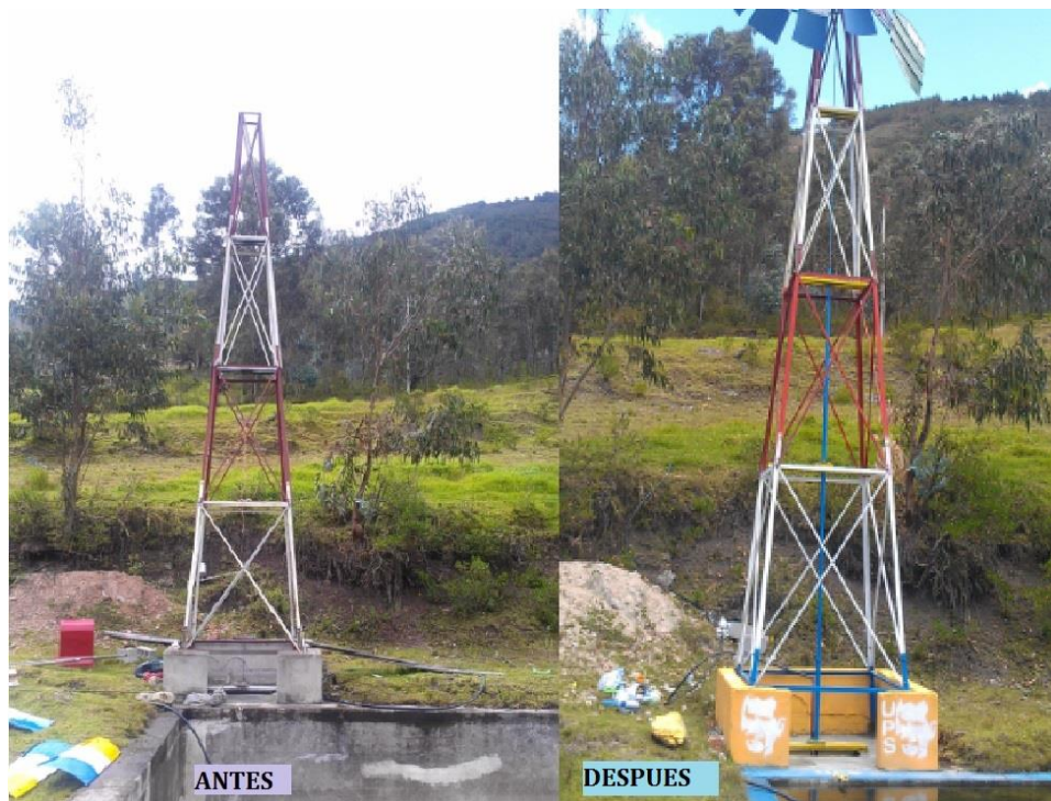
Fig. 3.6 Estructura de la torre
