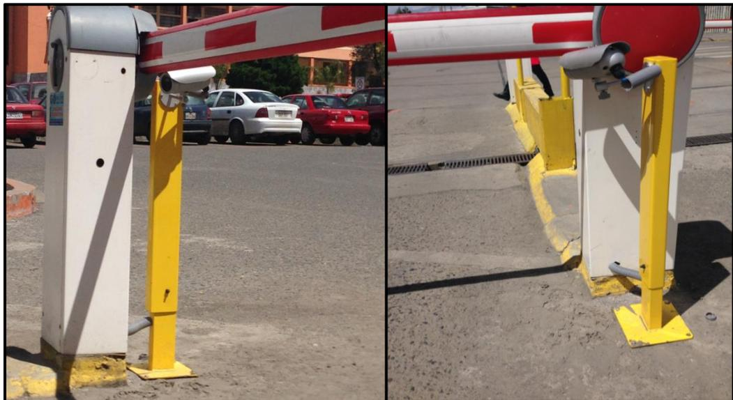
**FIGURA N 21 SOPORTE DE LA CÁMARA DE VIDEO**
