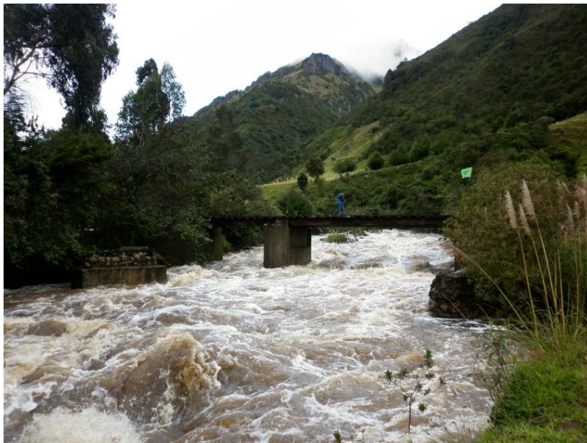
FOTO No. 10. PELIGRO DE DESBORDAMIENTO EN LA ZONA No. 2
