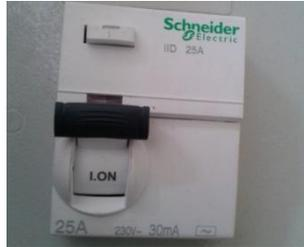
**Figura 3-15:** Switch principal del equipo
