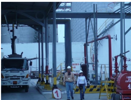
Inspección Instalaciones VOPAK
