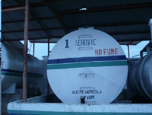
Inspección tanque reserva
