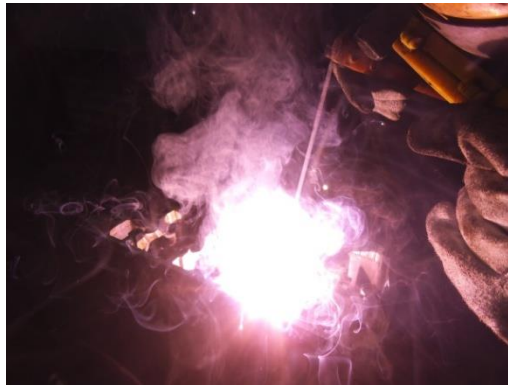
Fig. 4-17 Soldadura con electrodo de Aluminio AW 2201 E-4043. Fuente: Autores.
