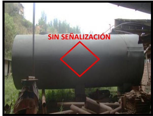
***Ilustración 77:*** Sin señalética en depósito de combustible
