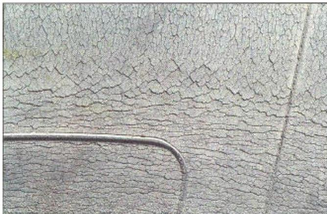
**FIGURA 8.a) Agrietamiento**
