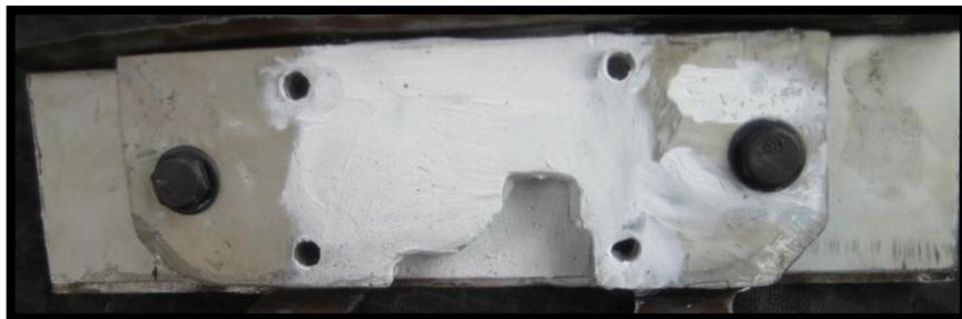
Grafico 42: Láminas de aluminio colocadas y sujetadas con dos pernos.
