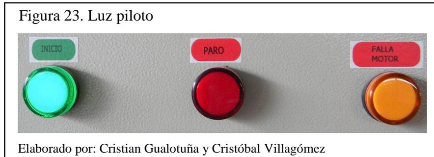
Generalmente los pulsadores se los utilizan para maniobras de arranque y paro, también para mandos de circuitos de seguridad (paro de emergencia) debido al ambiente industrial estos pueden ser metálicos cromados y totalmente de plástico, además estos pueden ser Normalmente abiertos (NA) o Normalmente cerrados (NC)
