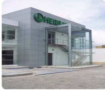
Figura 11. Obras varias aluminio compuesto
