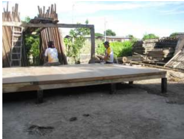
Figura 13. Tableros para la construcción del piso de una vivienda
