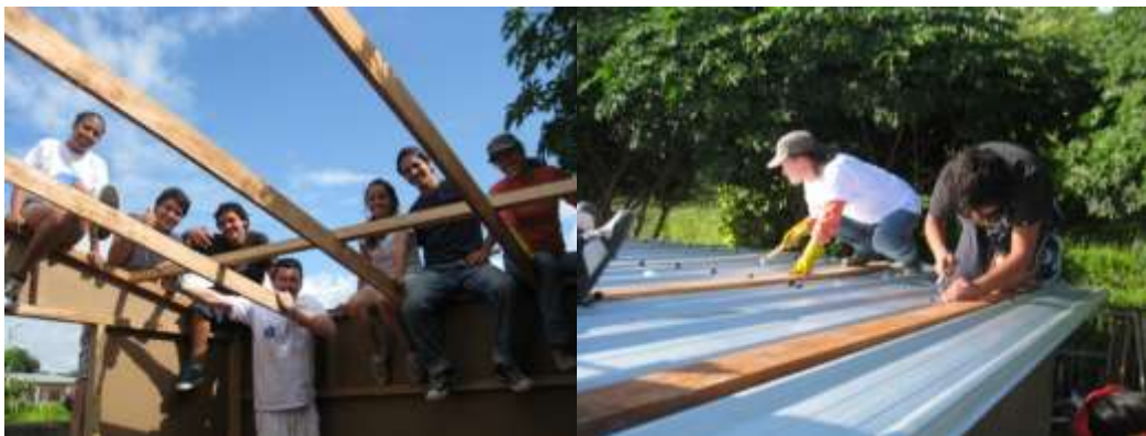
Figura 6. Armando el techo
