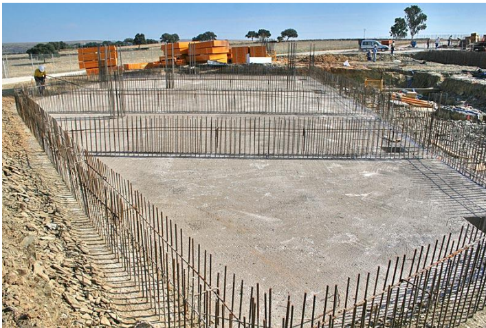
Figura 1.3 Losa de cimentación
