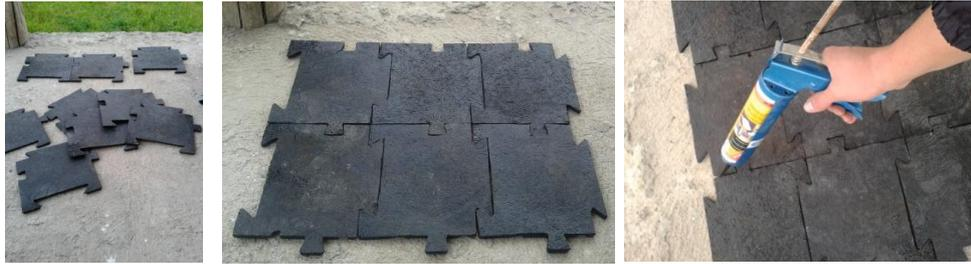
Fig. 4. 3 Montaje de los pisos RECICAUCHO. Fuente: Autor
