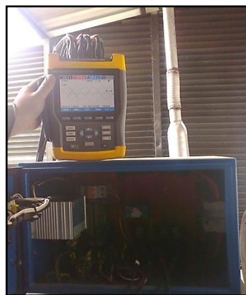
Figura #199. Analizador FLUKE 435 conecta en el tablero de control del generador
