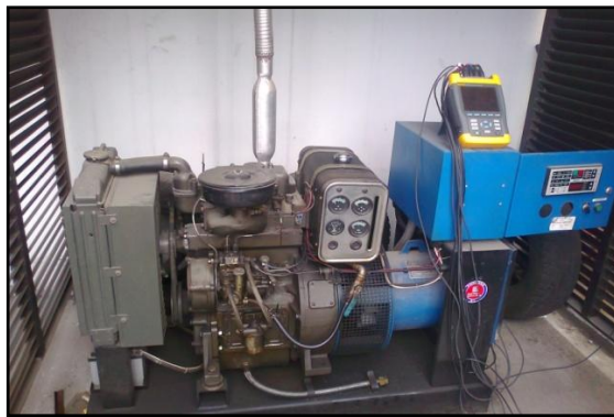
Figura #198. Instalación del analizador FLUKE 435 en el generador
