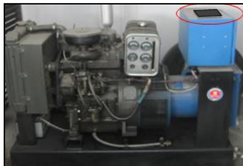
Figura #165. Módulo electrónico en generador.
