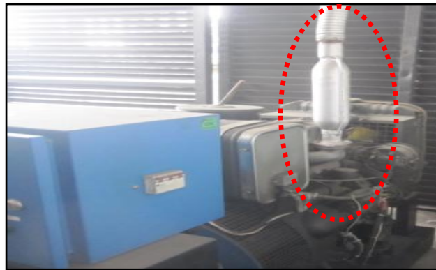
Figura #6. Generador, indicando por donde despiden los gases del motor
