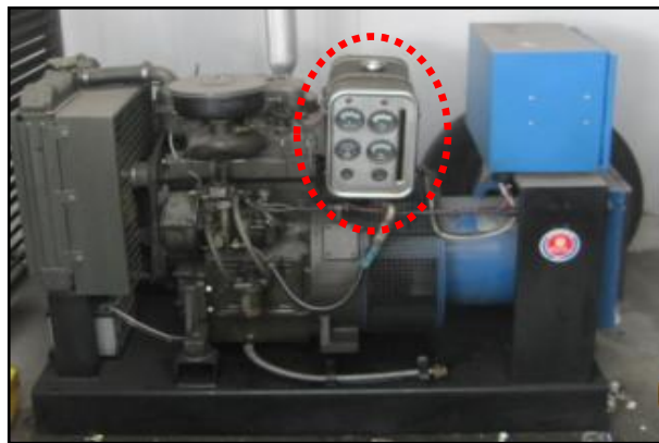
Figura #11. Tanque de combustible capacidad 4 gal.
