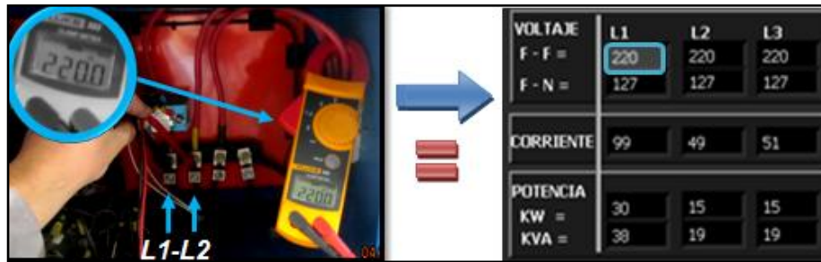
Figura #145. Voltaje L1-L2 en Pinza amperométrica Vs Voltaje en la PC
