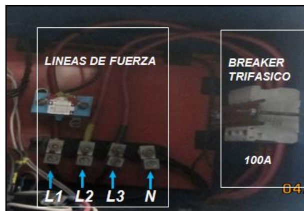
Figura #142. Tablero de cables de fuerza del generador
