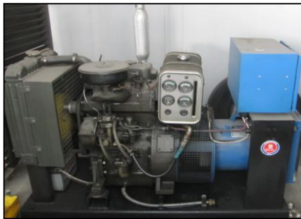
Figura #1. Grupo electrógeno CRAM ELETRO con una P=15KVA. 1
