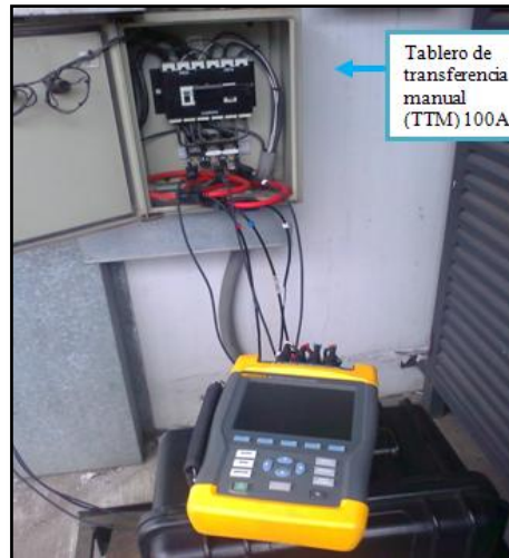
Figura #193. Instalación del analizador de carga FLUKE 435
