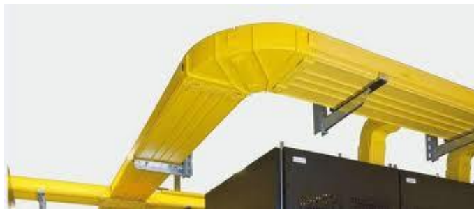
Figura 3.14. Canaleta utilizada para fibra óptica. [108]
