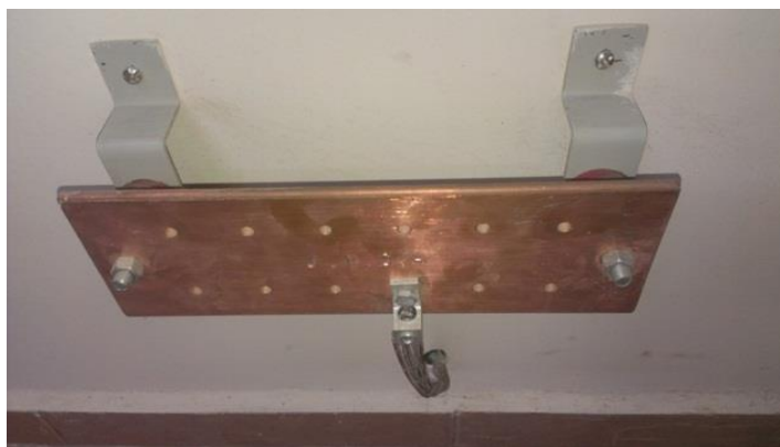
Figura 2.28. Placa de cobre perforada. Fuente: ETAPA E.P
