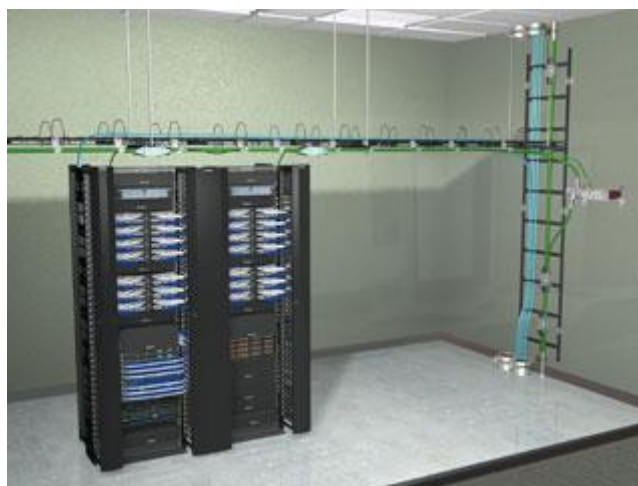
Figura 2.24. Bastidor de fibra en sala de telecomunicaciones. [111]
