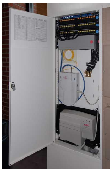
Figura 3.3. Gabinete de distribución de servicios en una conexión FTTH. [112]
