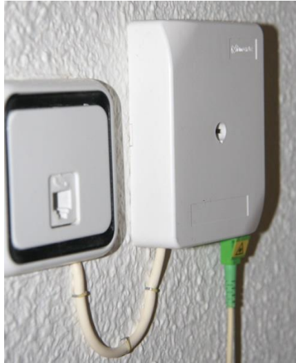
Figura 3.12. Roseta óptica adosada en Pared (Soluciones FTTH). [77]
