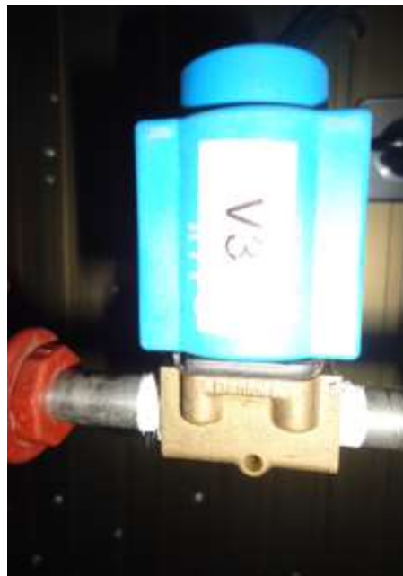
FIGURA 55: ELECTROVÁLVULA MARCA DANFOSS DE ¼"
