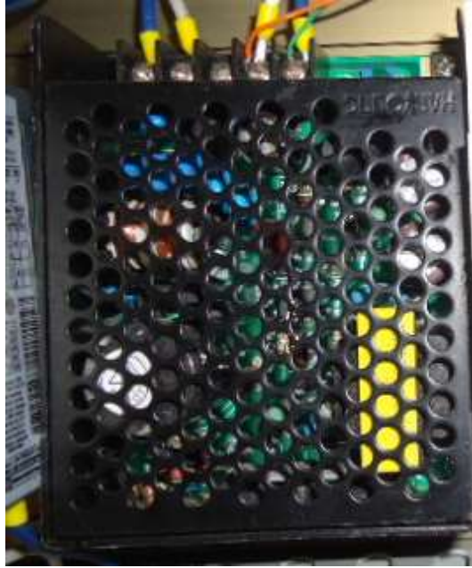
FIGURA 73: FUENTE DE VOLTAJE IN 120V Ac - OUT 24V Dc
