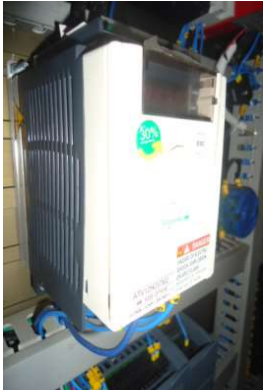
FIGURA 74: VARIADOR DE VELOCIDAD - ATV12
