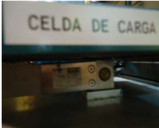
FIGURA 69: CELDA DE CARGA INSTALADA
