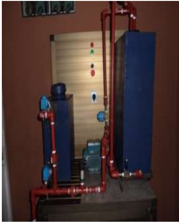
FIGURA 41: MONTAJE DE TANQUES Y EQUIPOS
