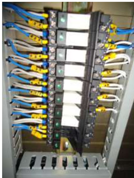
FIGURA 59: RELÉS DE OPERACIÓN
