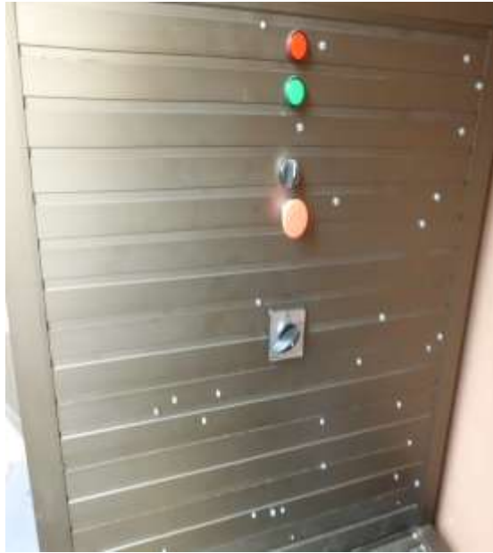
FIGURA 36: MONTAJE DE EQUIPOS Y ACCESORIOS
