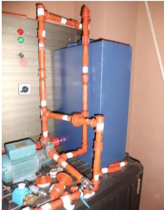
FIGURA 40: MONTAJE DE TUBERÍAS Y ACCESORIOS PVC
