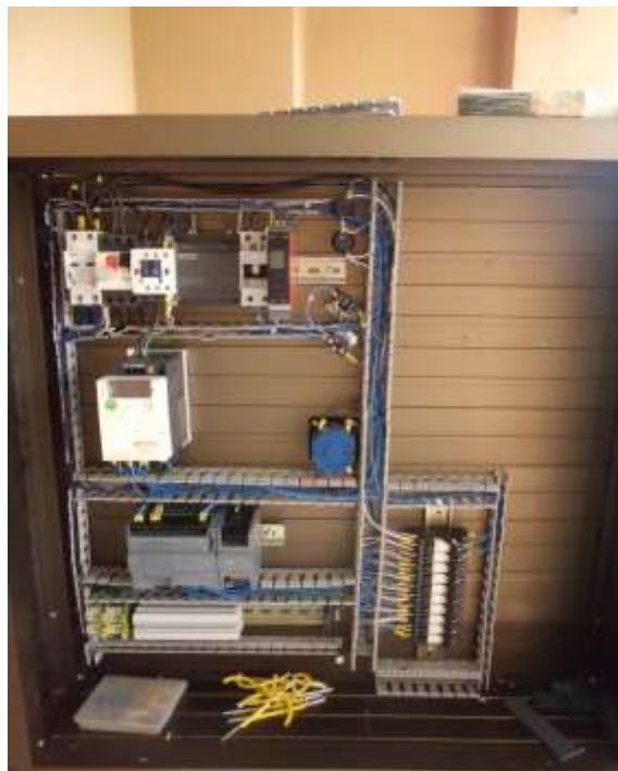
FIGURA 37: MONTAJE DE EQUIPOS Y ACCESORIOS
