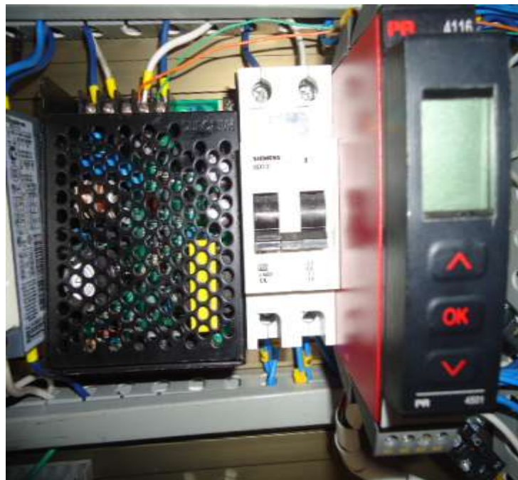
FIGURA 43: CONTROLADOR O INDICADOR DE PESO PR 4116
