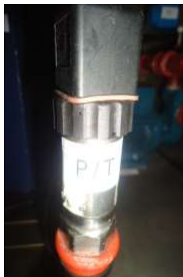
FIGURA 65: TRANSMISOR DE PRESIÓN INSTALADO
