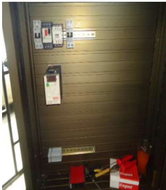
FIGURA 35: MONTAJE DE EQUIPOS Y ACCESORIOS
