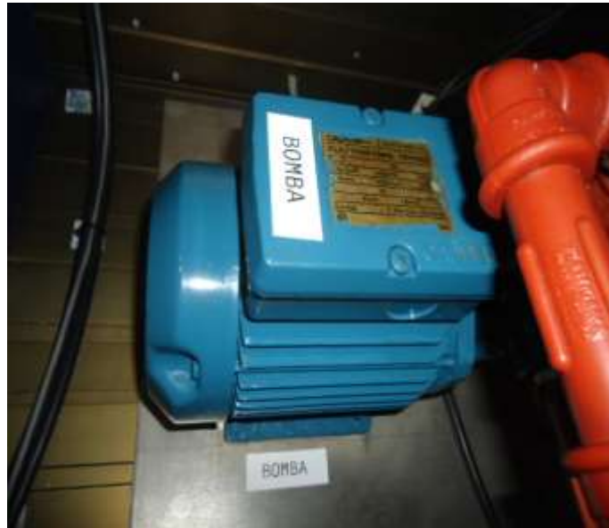
FIGURA 54: BOMBA TRIFÁSICA DE ½ HP
