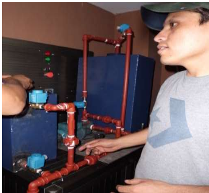
FIGURA 42: MONTAJE DE EQUIPOS E INSTRUMENTOS
