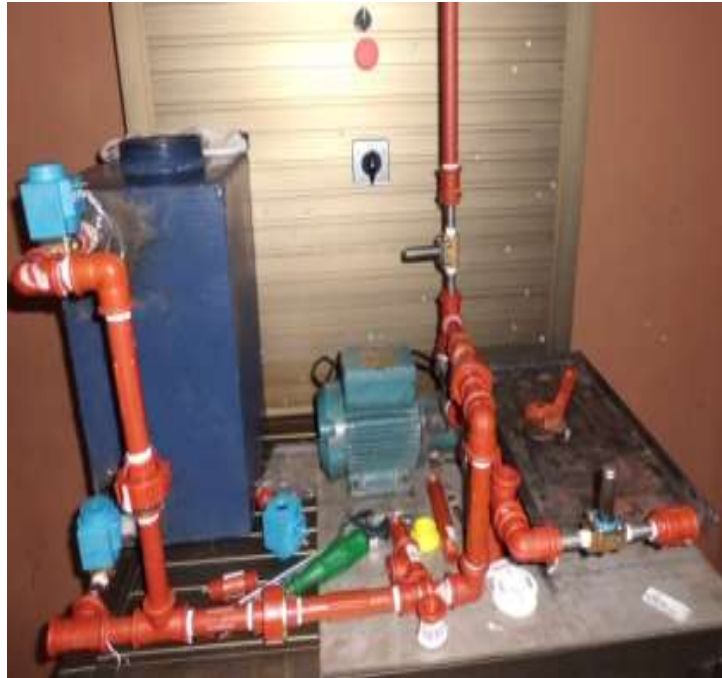
FIGURA 39: MONTAJE DE TUBERÍAS Y ACCESORIOS PVC
