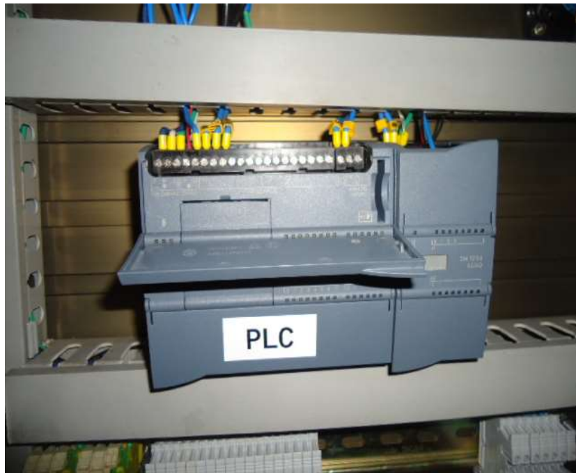
FIGURA 56: PLC 1200 / SIEMENS
