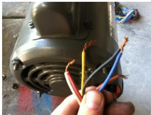
Figura 3. 36. Conexión de los cables.
