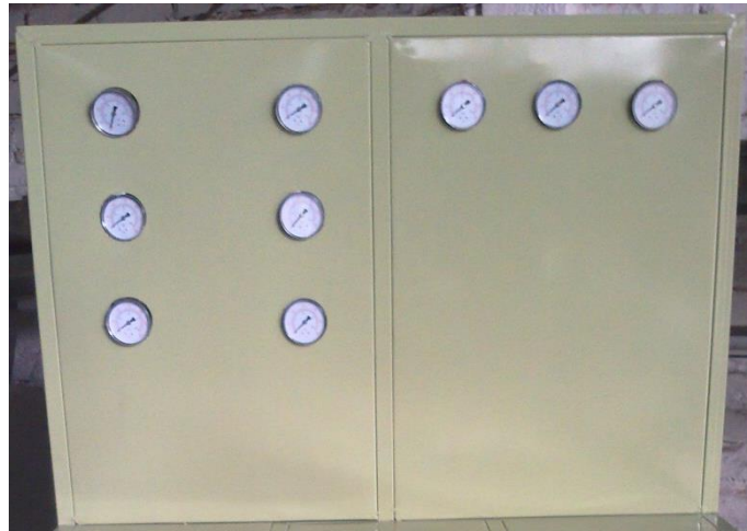
Figura 3. 78. Manómetros para presión hidráulica.
