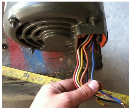
Figura 3. 35. Conexión de los cables.
