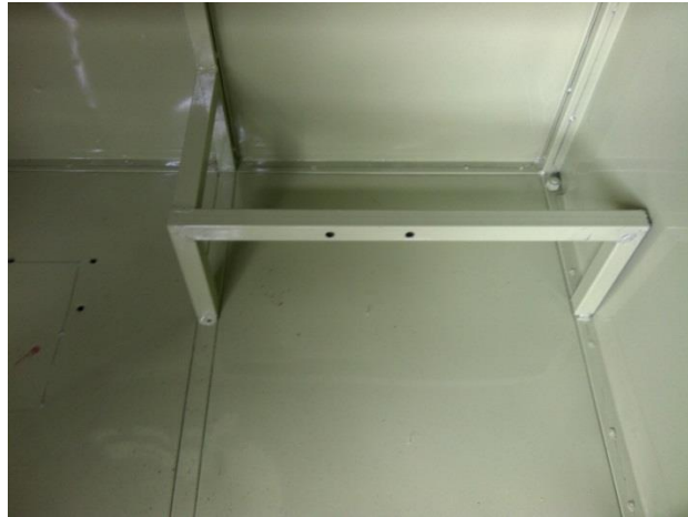
Figura 3. 27. Base de la bomba hidráulica.
