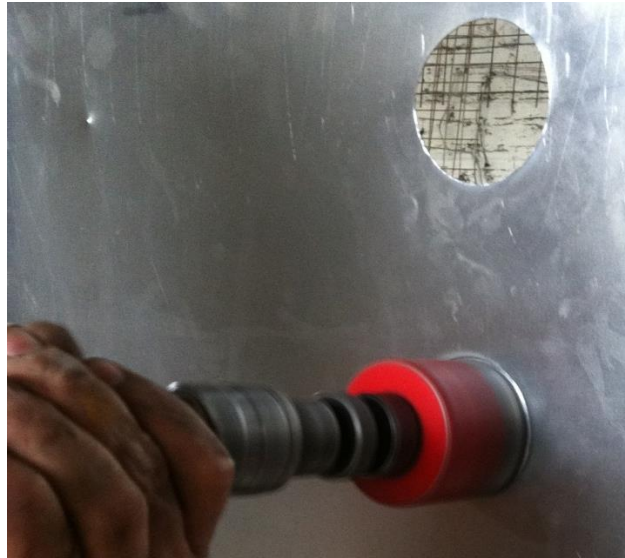
Figura 3. 23. Corte de la palca de acero.
